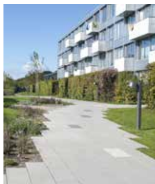
Betonfliser med diffus kant.
