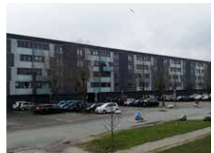
b. Parkeringsareal ved bygning
